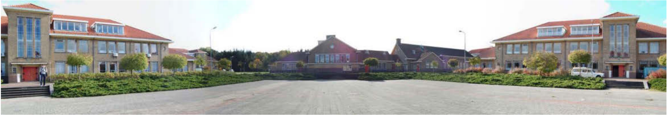
In het midden het keukengebouw van de Elias Beeckmankazerne in Ede, geflankeerd door legeringsgebouwen (Bouwhistorisch onderzoek Elias Beeckmankazerne in Ede, Arcx)
