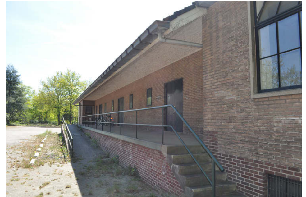
Laadperron aan de oostgevel
