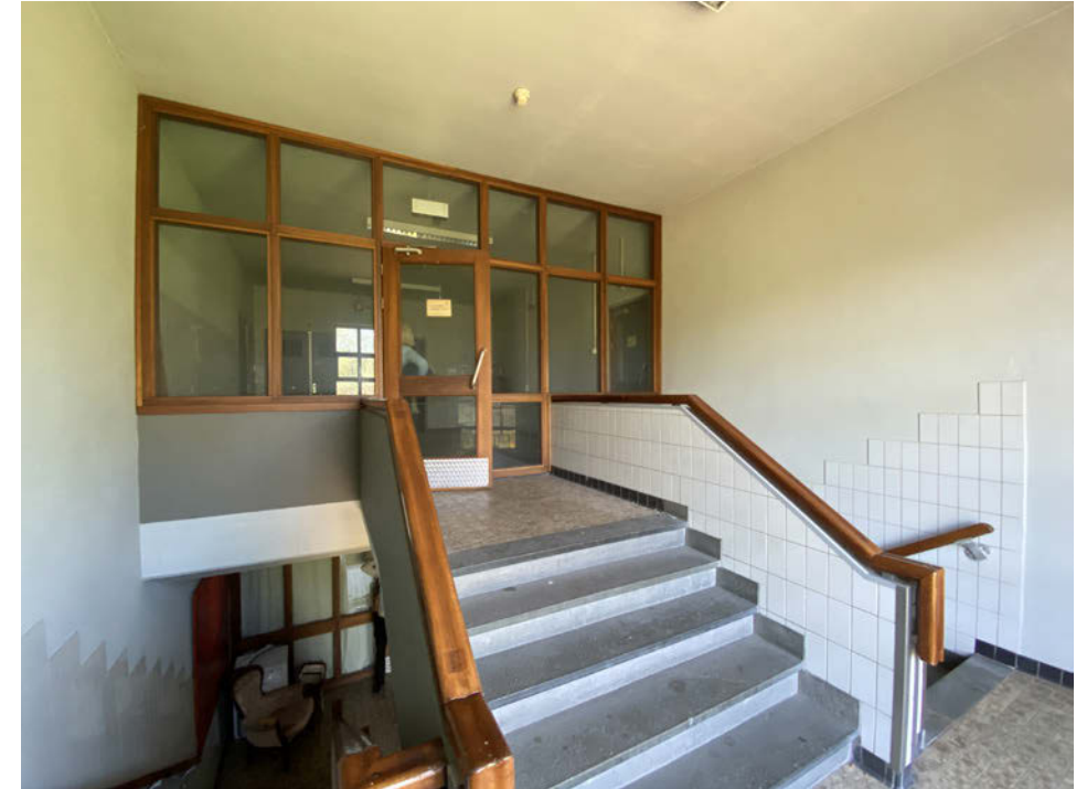
Later aangebrachte brandscheidingen tussen de gangen en de trappenhuisen, 2020
