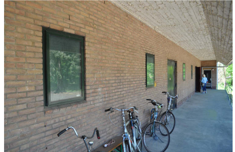
De jongere westgevel met nieuwe ramen en deuren
