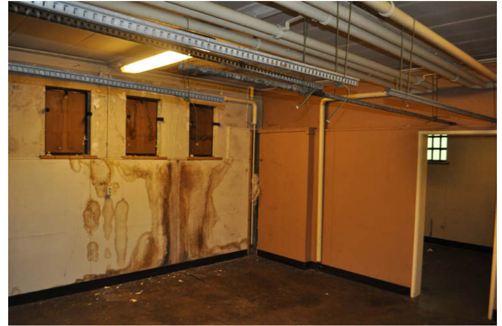
Het oorspronkelijke interieur is uitgebroken
