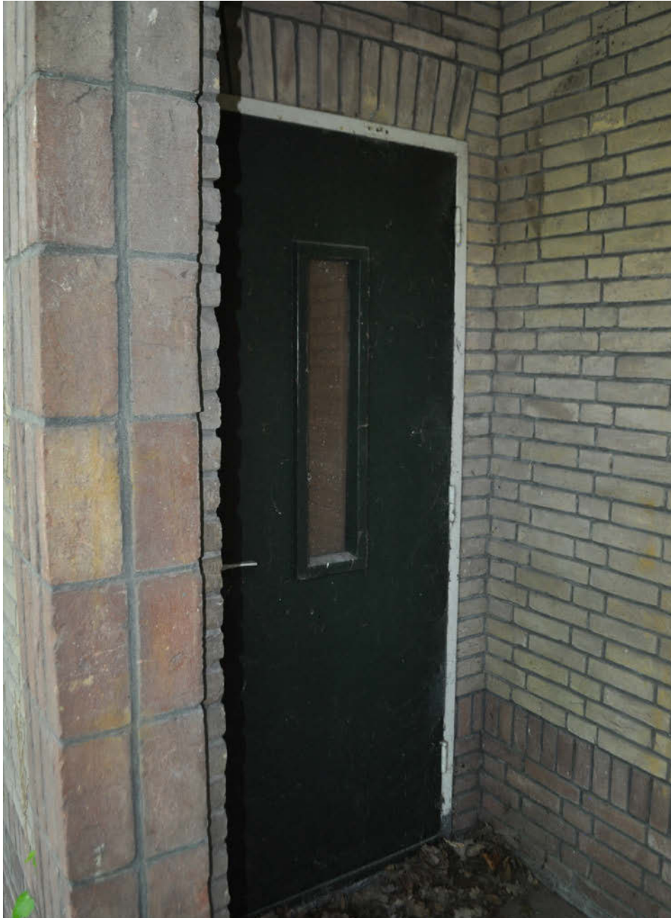
Ingang achterzijde gebouw 7
