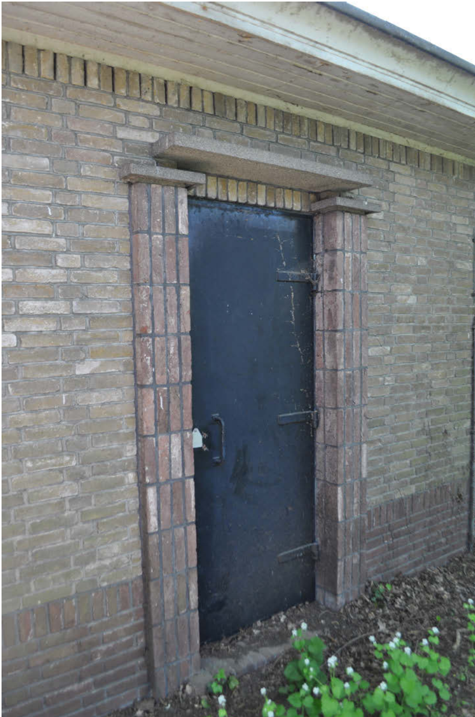
Entree in de korte zijde, met karakteristieke verfraaiing en rollaag onder de dakrand
