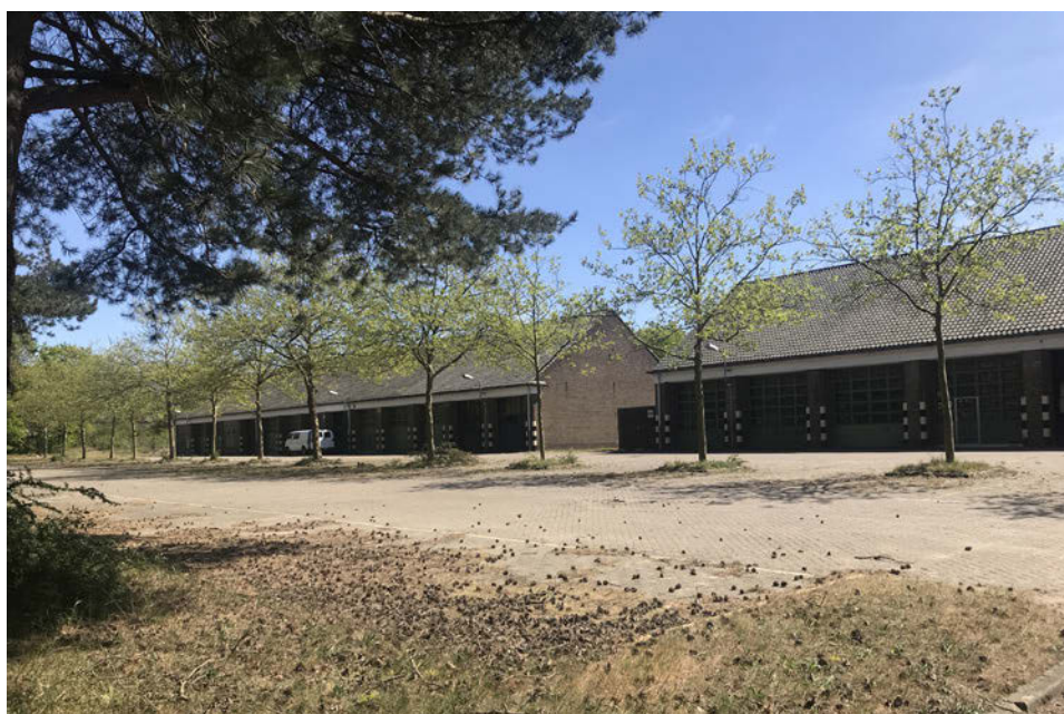
Voormalige garagegebouwen (gebouwen 20 en 21) waarmee gebouw 22 een stedenbouwkundig ensemble vormt
