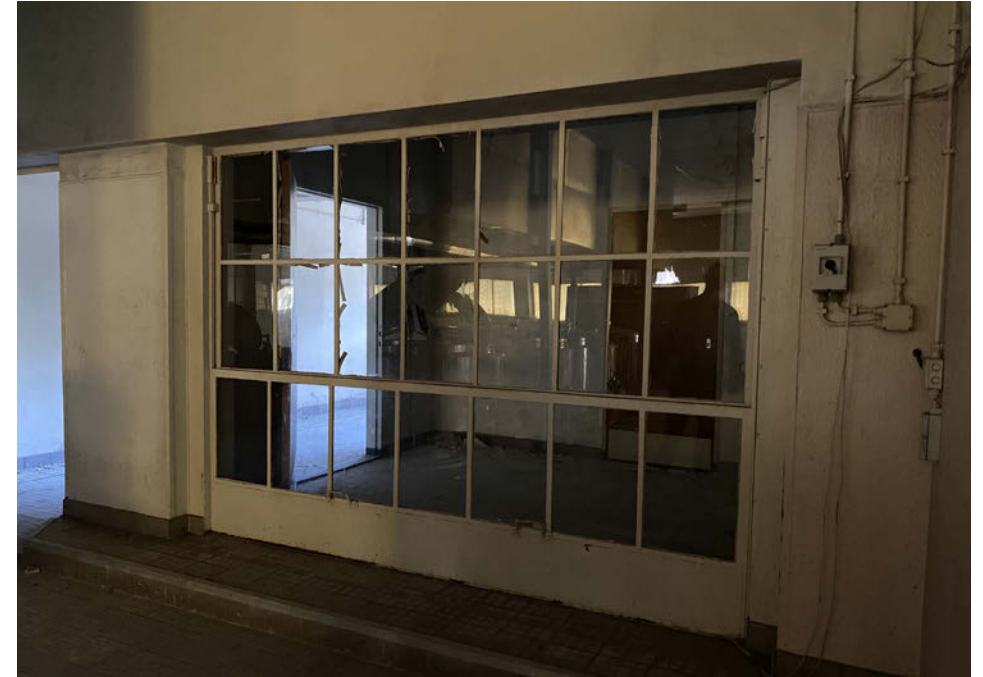
Stalen kozijnen in het keukengebouw
