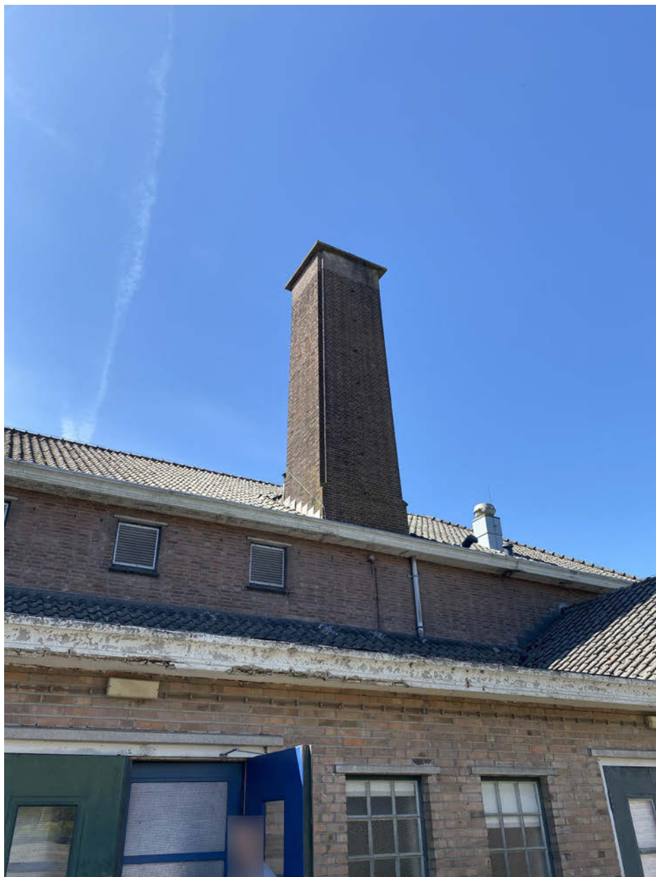
Schoorstenen van het keukengebouw. Let op de sprong in het metselwerk op de hoeken, 2020
