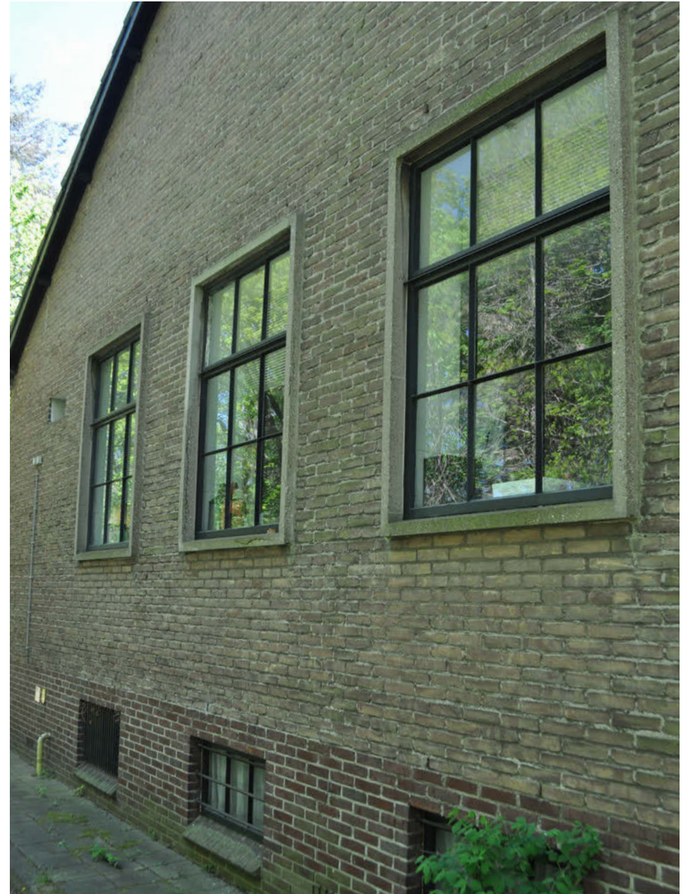
Ramen in de noordelijke kopgevel met betonnen omlijsting
