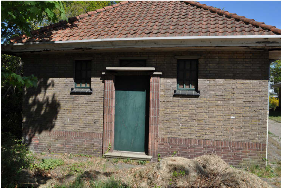
Kopgevel, entreepartij met bovenlicht
