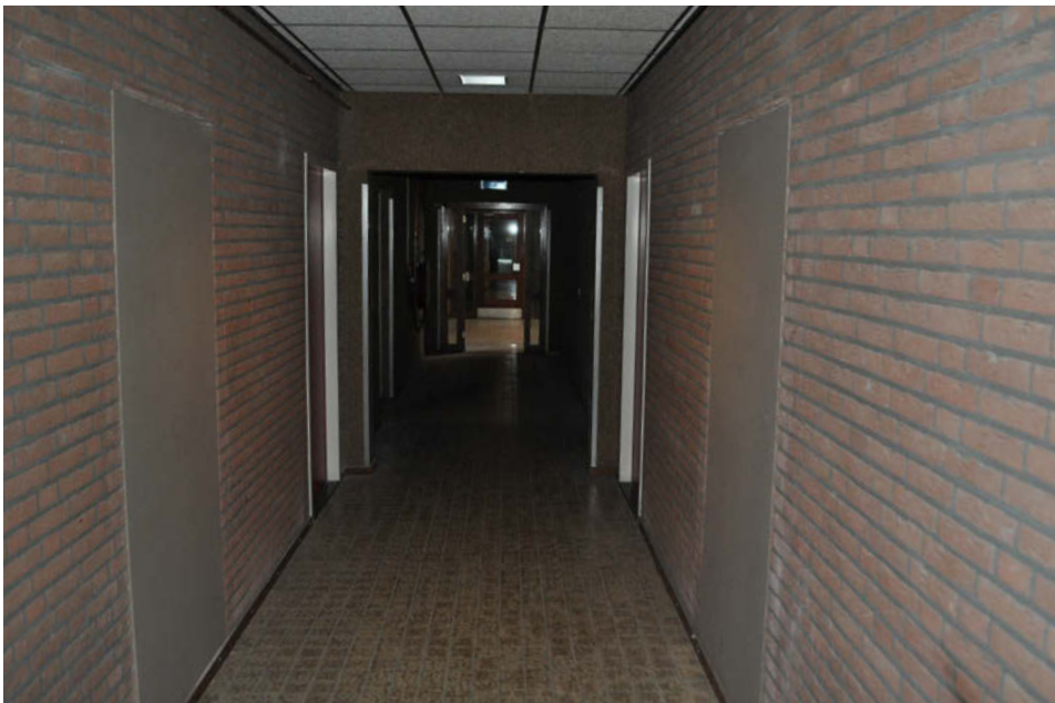
De gang met wanden in schoon metselwerk
