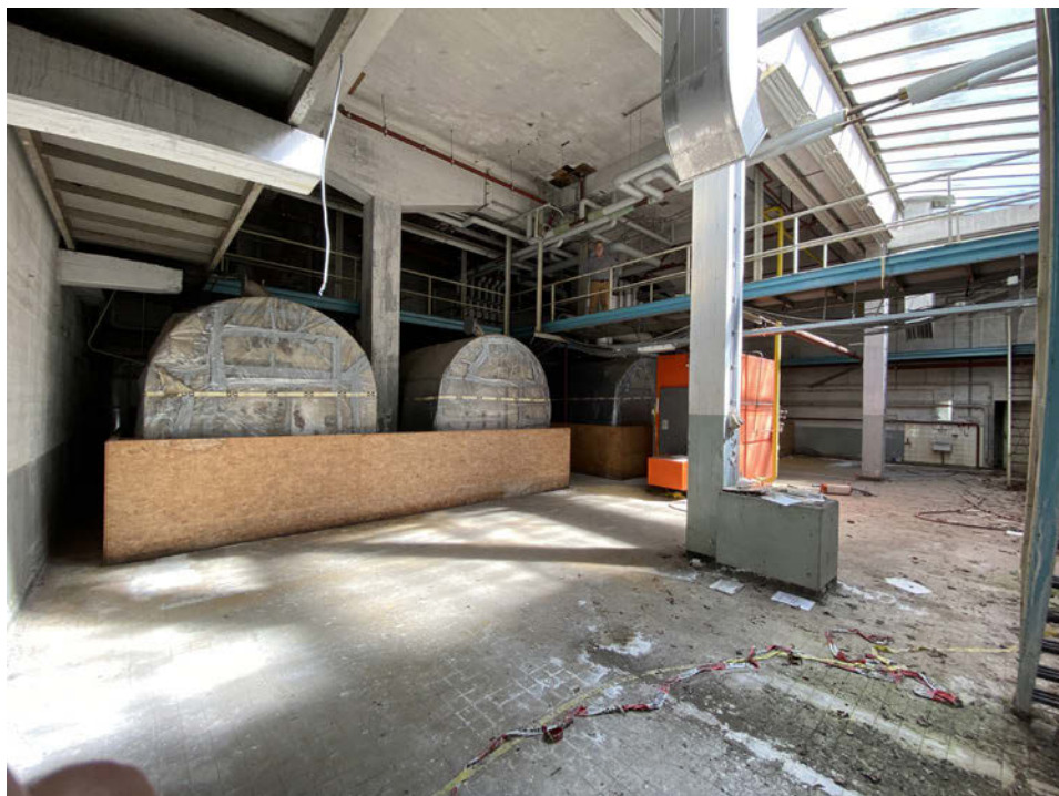
Het interieur van het ketelhuis
