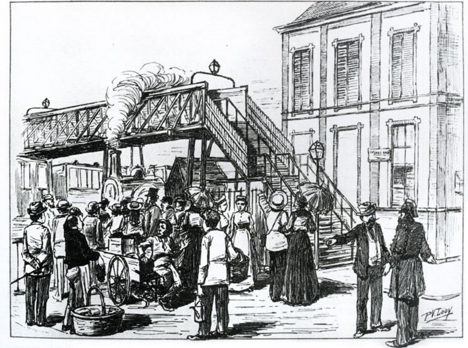
Problemen bij spoorwegovergangen, beeld uit K. van Giffen
