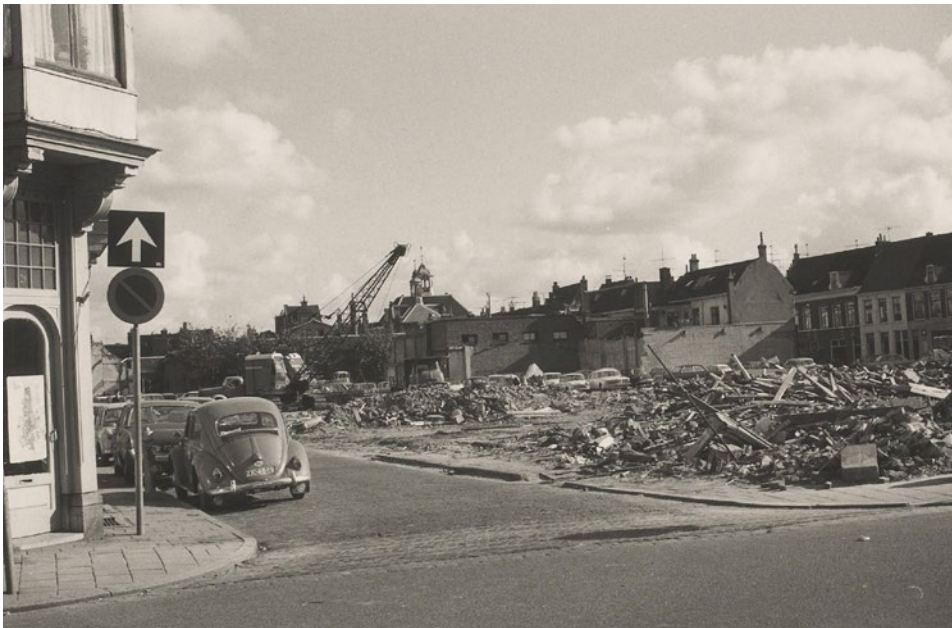
Sloop aan de Lange Herenstraat, 1967
