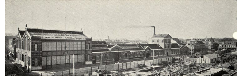
Beijnesfabriek tijdens de bouw van het huidige station, omstreeks 1905
