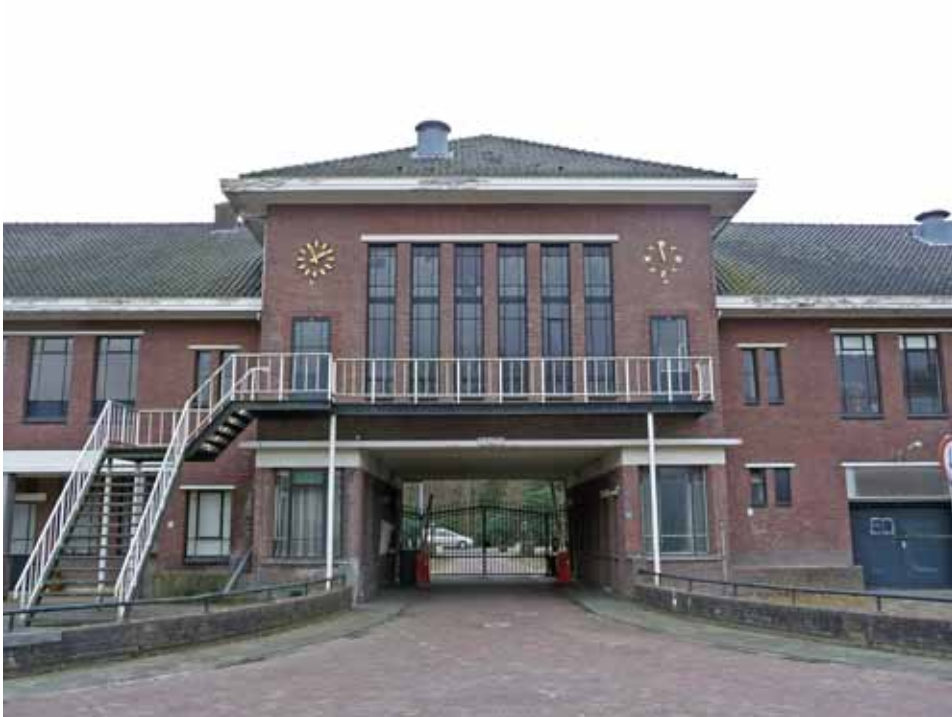
Poortgebouw aan de appelplaats (links) en aan de Oirschotsedijk (rechts)
