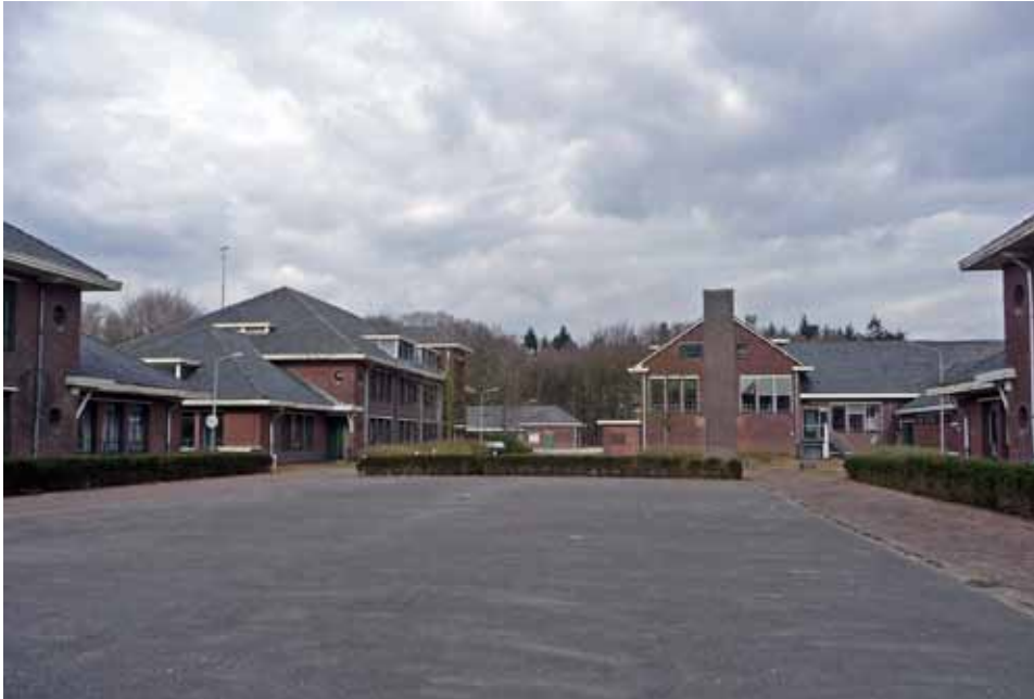
Appelplaats met Keukengebouw
