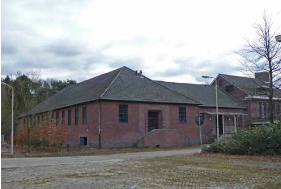
Duitse manschappenzaal en de officiersmess bij de Duitse Woningen
