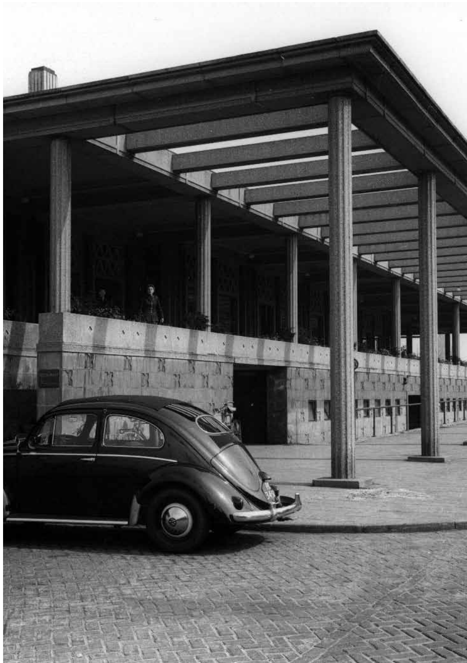
Terras onder pergola met helemaal links in het basement de trap naar het terras, middenin de opening naar de trap naar de hal en rechts nog te zien de opening naar de fietsenkelder
