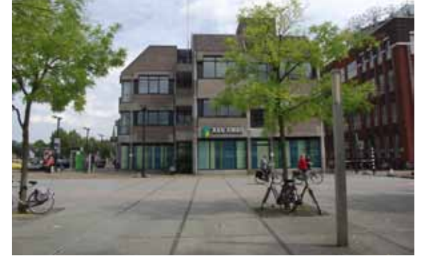
ABN-AMRO gebouw uit de jaren '80
