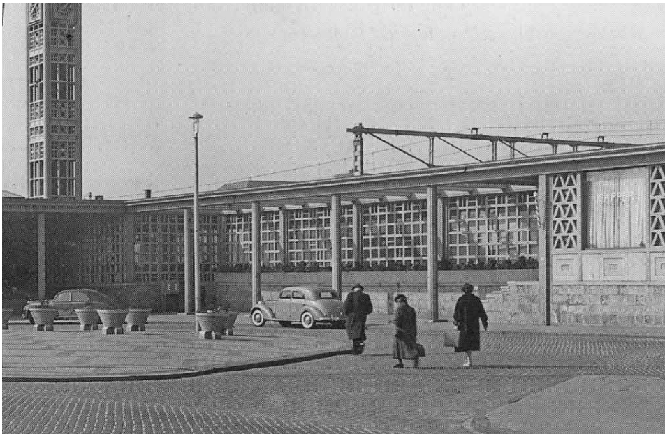
Noordelijke uitbouw langs het stationsplein en het langspoor
