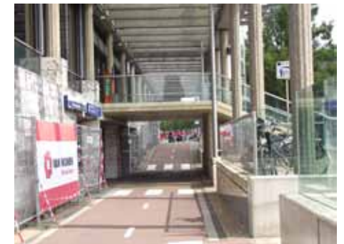
Fietspad en ramp naar kelder
