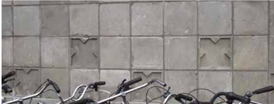
De betontegels in het basement van het station in hun huidige toestand
