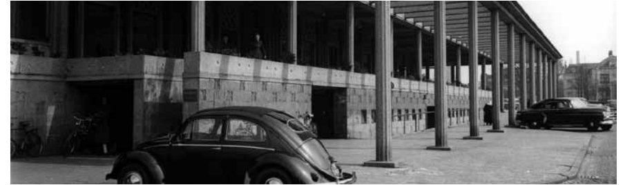
De oorspronkelijke gevel van het station aan de zuidzijde
