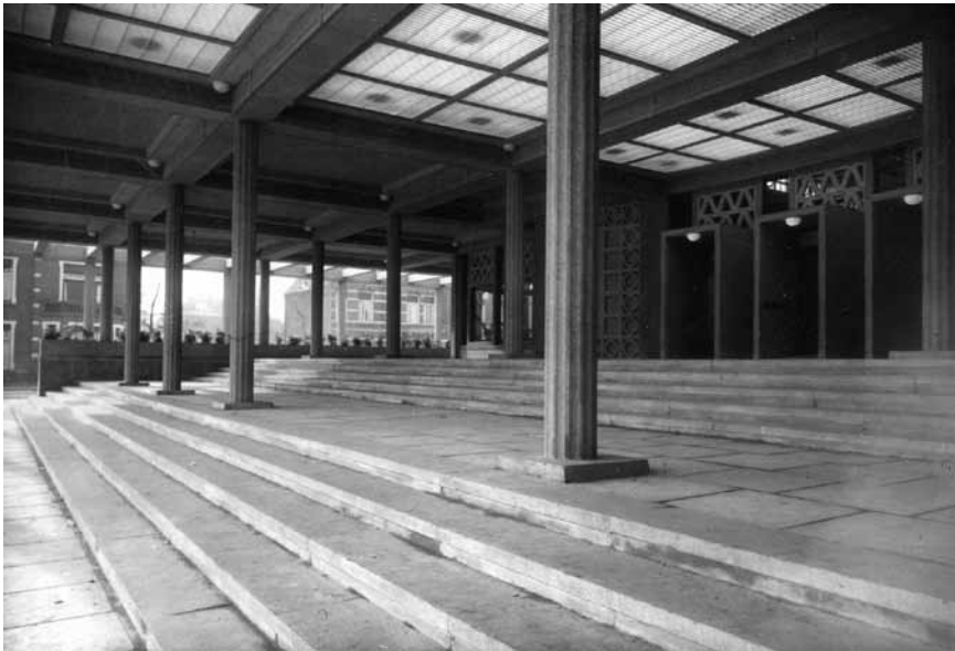
Peristyle met trappen naar de ingang
