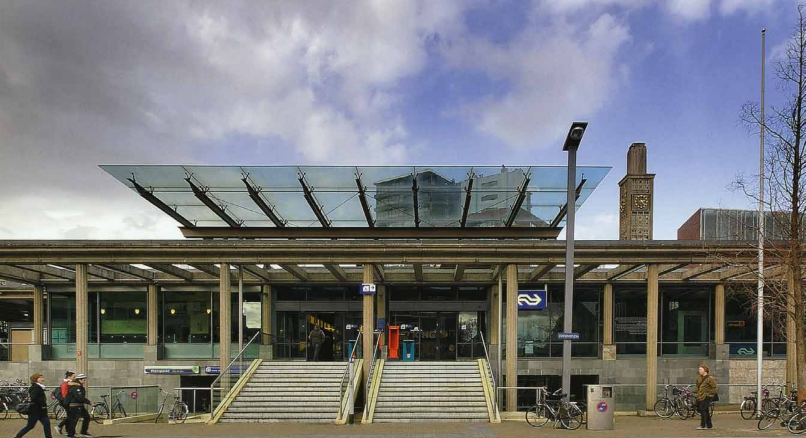
Nieuwe entree in Zuidgevel
