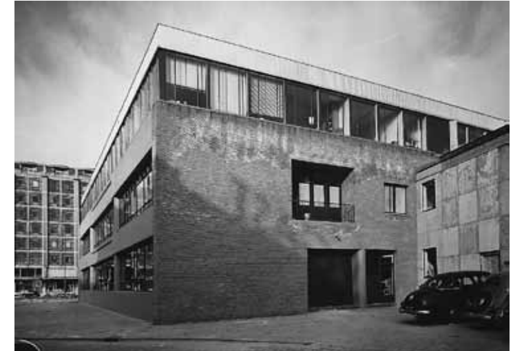
Oorspronkelijke aansluiting tussen het Tentoonstellingsgebouw en de eerste uitbreiding
