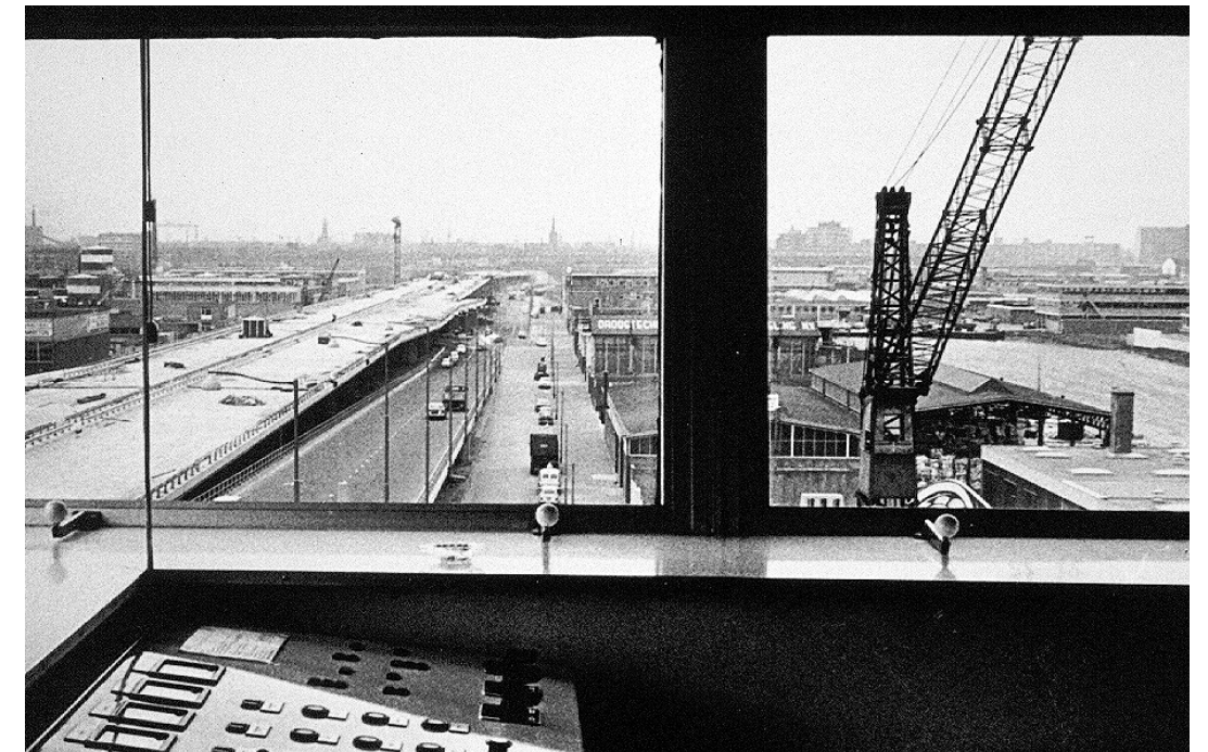
Aanleg rijksweg 20 met afrit bij de Industrieweg
