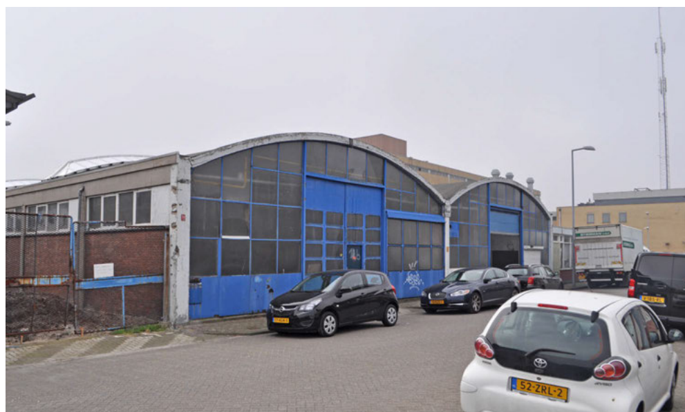
Boogspant constructie aan de Bornissestraat
