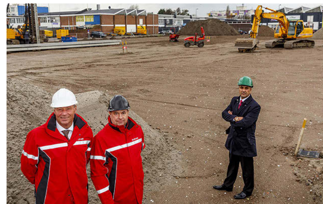
Terrein van de Spaanse Toren na sloop (bron: Loxam)
