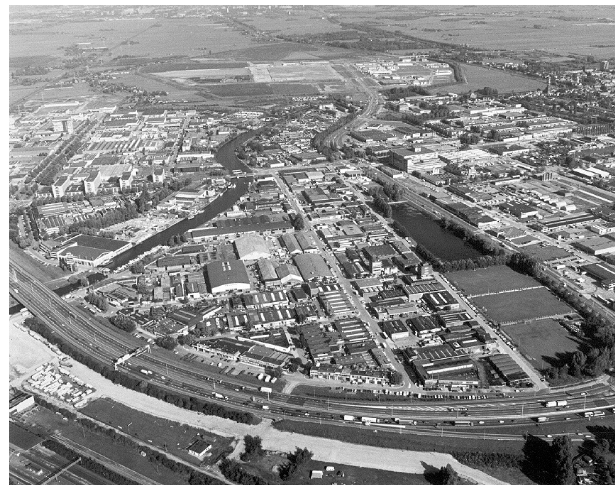
Luchtfoto van de groene wig, met daaraan grenzend de kleinschalige bebouwing aan de Thurledeweg
