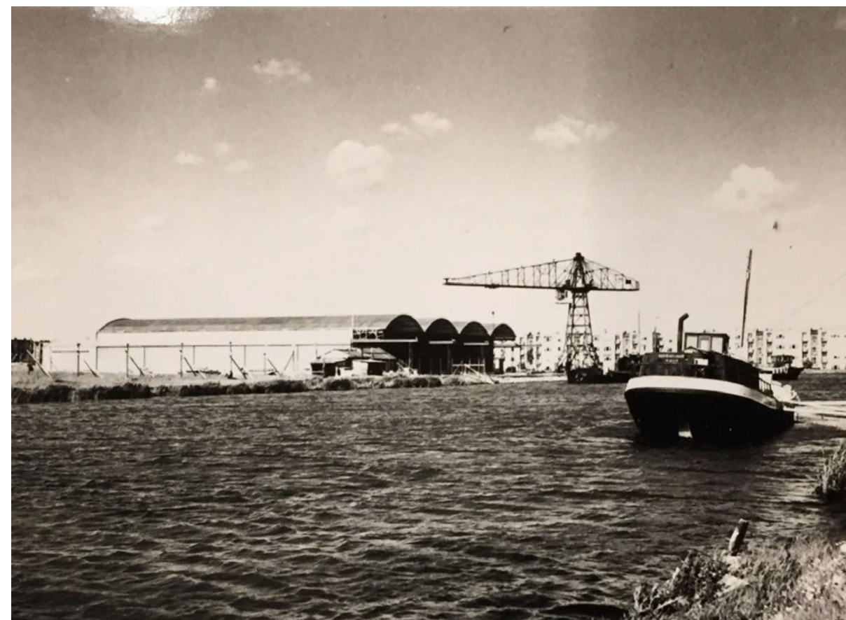
Opslaghallen van W.B. Diepeveen en Co in aanbouw
