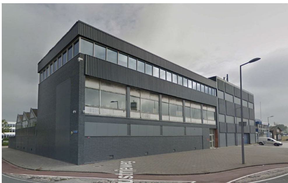
Bedrijfspannd van Kraaijvanger Architecten aan de Giessenweg voor en na overschildering
