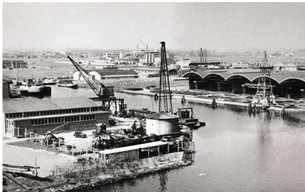
Loods met tonschalen van Diepenveen aan de Gantelhaven
