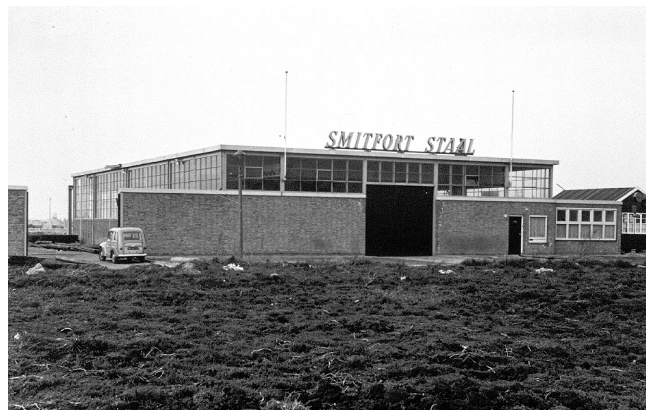
Smitfort Staal aan de Giessenweg
